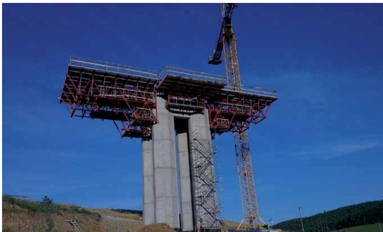
Con mensole rampanti MK sono stati realizzati getti di 4m di altezza With MK Climbing Brackets, tiers of 4 m height were poured
