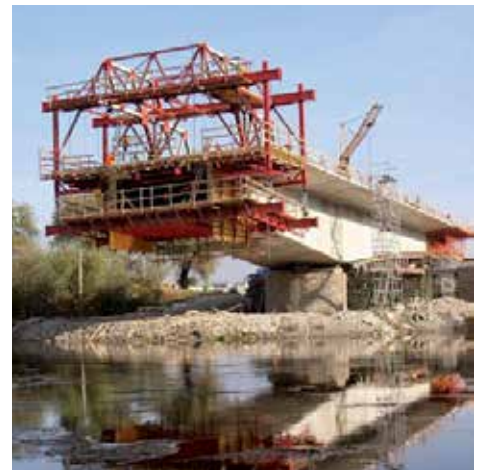
Ponte Autostradale SO224-00 Dubna Skala - Turany (SK) Hightway Bridge SO224-00 Dubna Skala - Turany (SK)
