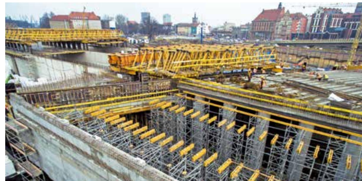
Oltre a questi lavori, ULMA ha fornito attrezzature per due viadotti con cinque vani ciascuno. Quelli esterni sono stati costruiti con torri di carico T-60, mentre per quelli interni sono stati utilizzati elementi prefabbricati.
