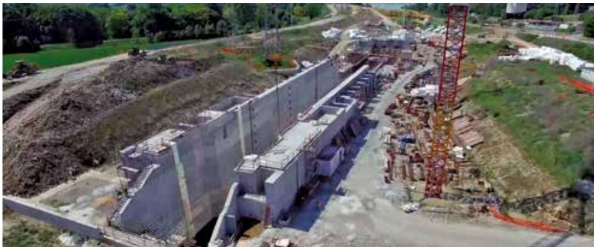
Durante la costruzione dei muri perimetrali, alti più di 30 m e con strati di 6 m, sono stati applicati gli standard di sicurezza e seguite le tempistiche stabilite dal cliente. Ricoprendo più di 320 m in lunghezza e 5000 m<sup>2</sup>, i muri alti 15 m sotto il livello dell'acqua sono stati installati in 8 sezioni da 20 m.
