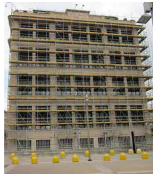
Per accedere al ponteggio sono state fornite 2 torri scala alte 26 m e per permettere lo smontaggio e il trasferimento delle veneziane al restauratore sono stati creati dei passi carrai di larghezza circa 5 m creando gli spazi atti alle movimentazioni.
