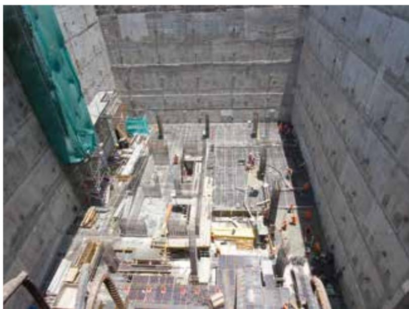
Essendo uno spazio destinato a ospitare uffici di classe A+, era necessario ottenere ampi solai con superfici di alta qualità per un'area di 854 m<sup>2</sup>. **Per la prima volta nel paese è stata utilizzata una cassaforma modulare di alluminio CC-4**, che permette di soddisfare i requisiti architettonici nel risultato del getto. Il sistema CC-4 è costituito da parti leggere e riutilizzabili, tanto che nel giro di 5 giorni la stessa cassaforma può essere riutilizzata per i piani successivi.
