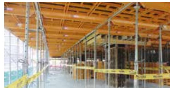
Il sistema è molto economico. Il montaggio da terra dei pilastri e dei pannelli garantisce un lavoro in un ambiente sicuro ed evita qualsiasi possibilità di caduta dalla cassaforma. In più, sono necessari meno puntelli per m<sup>2</sup>, lo spazio per l'assemblaggio è più ampio e il transito nella zona di lavoro è facilitato.
