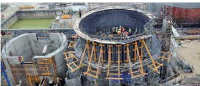
Con questo nuovo prodotto ULMA rafforza la propria gamma di casseforme circolari, integrando le funzionalità di ENKOFORM VMK e ENKOFORM V-100 per realizzare qualsiasi parete circolare, sia con raggio fisso che variabile, serbatoi d'acqua, aree di stoccaggio, tunnel, o qualsiasi altra applicazione.
