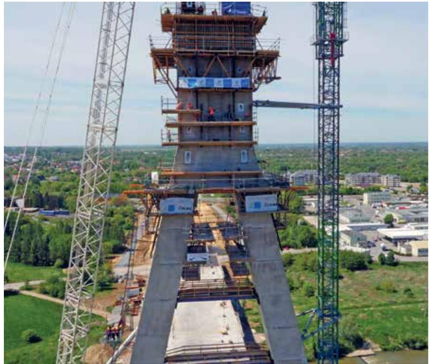
Gli elementi scatolari del pilone misurano 5,75 m per 4,75 m e hanno spessori variabili da 1,30 m a 0,80. ULMA ha fornito 2 attrezzature auto rampanti ATR complete di sistemi meccanici e idraulici che hanno permesso al sistema di avanzare in elevazione senza l'ausilio di gru.
