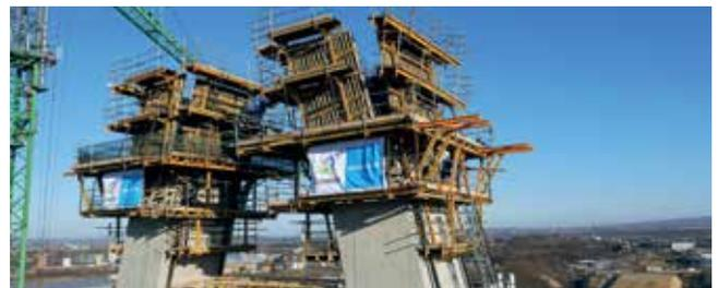
Nella fase iniziale sono state completate le basi di sostegno della pila. I vari elementi con altezza di 14,5 m e con sezione a T sono stati realizzati utilizzando il sistema autorampante con cassero ENKOFORM VMK. Per garantire la sicurezza del personale impegnato nella realizzazione degli elementi inclinati della struttura, il sistema di cassetteria è stato dotato di 4 piattaforme di lavoro complete collegate tra loro.
