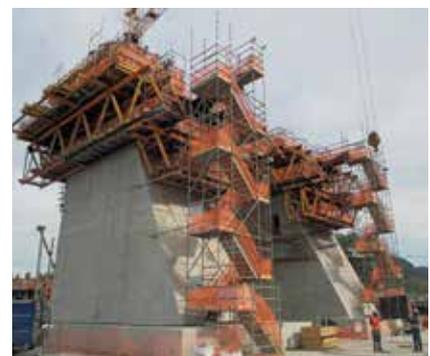
**E' LA PRIMA VOLTA CHE IN AMERICA LATINA VIENE UTILIZZATO UN SISTEMA AUTORAMPANTE PER COSTRUIRE I PILONI INCLINATI DI UN PONTE STRALLATO.**
